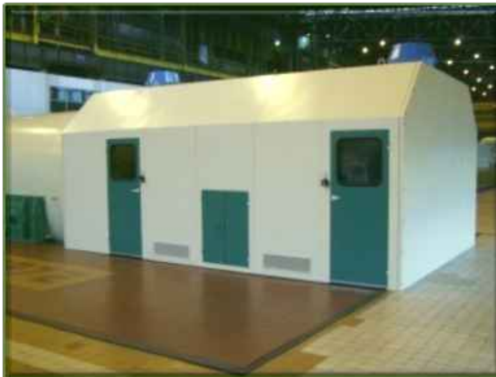
Obudowy dźwiękochłonna – izolacyjne wzbudnic generatorów. Skuteczność 18 dB(A)
