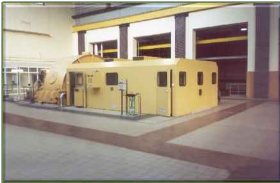
Obudowy generatora ze szczotkotrzymaczem. Skuteczność 20 dB(A)
