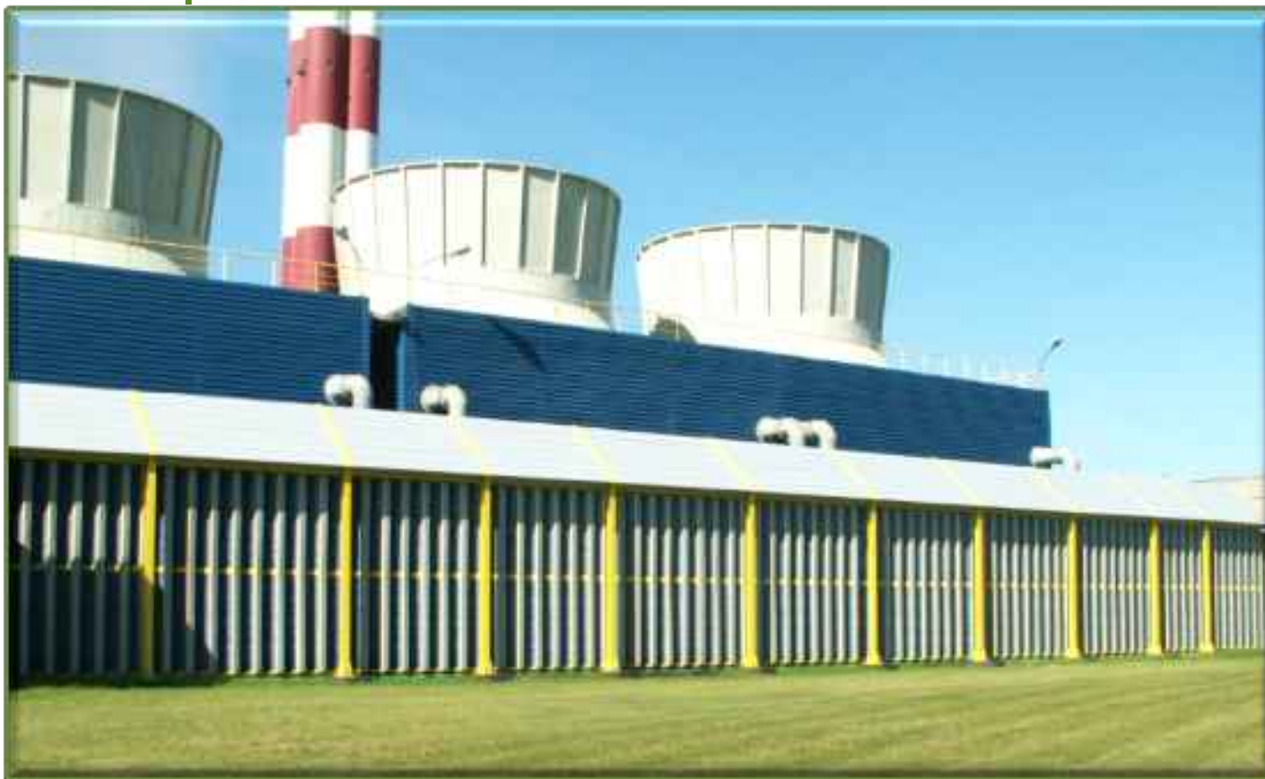
Ekran specjalny chłodni wentylatorowej. Skuteczność 12 dB(A)
