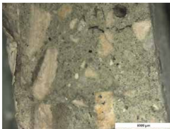
FOT. 3 Tynk szlachetny elewacyjny – próbka 2
