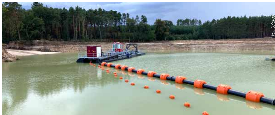
POGŁĘBIARKA SSĄCA produkcji EKO BUD II z rurociągiem
