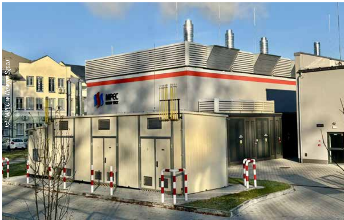
KOGENERACJA 6 MW w Elektrociepłowni Lwowska
