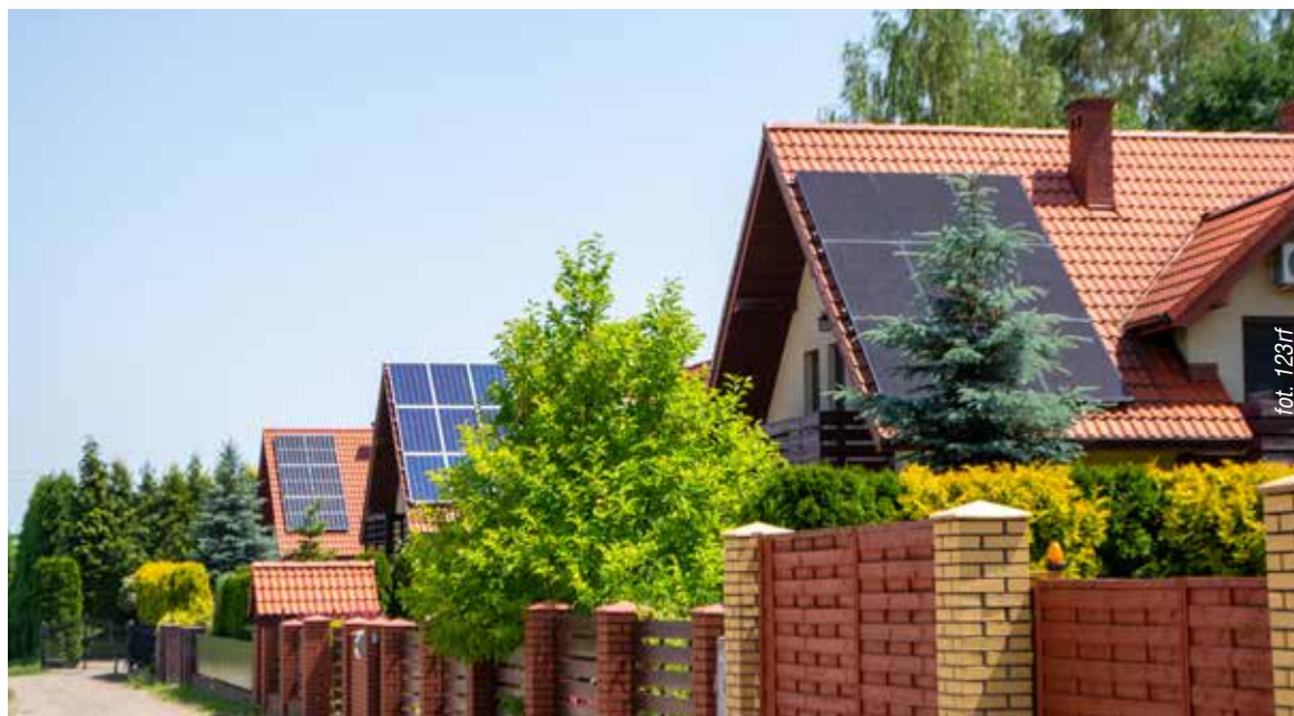
ZASTOSOWANIE MAGAZYNU przy instalacji PV włączonej do sieci po 1 sierpnia 2024 r. stało się warunkiem koniecznym dla uzyskania dotacji z programu Mój Prąd 6.0
